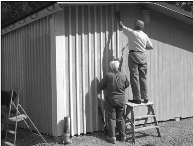
Alf Ericsson på marken och Rolf Nyberg spikar läkt på nya förrådet i gassande sol.
