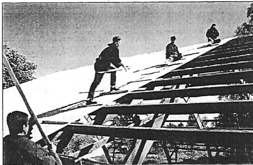
I början av juni började arbetslaget lägga undertaket.
