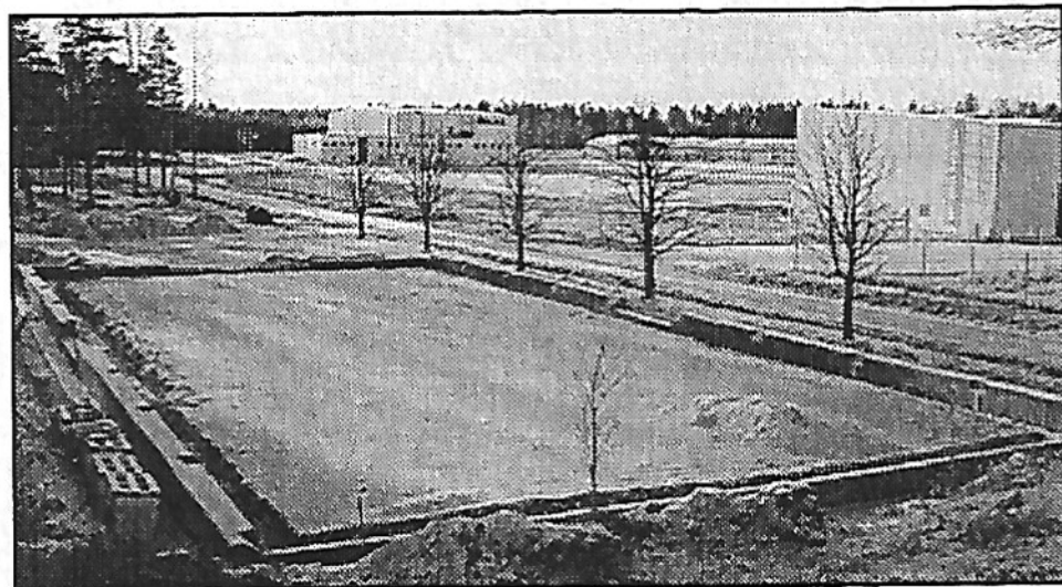
Grunden till taket är klar. De i originalutförande använda betongplintarna har ersatts av en hel sockel.
