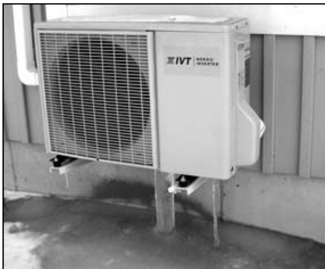
Luftvärmepumparnas utomhusdel jobbar hårt i kylan och kondensvattnet skapar små islandskap
