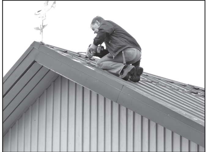
Sune Karlsson högst upp vid taknocken för att dra i nya skruvar och täta plåtskarvarna.
