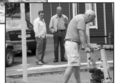
Byggledaren Sören Wennerberg packar mark medan byggmästaren PO Pettersson och T. Eriksson övervakar.
