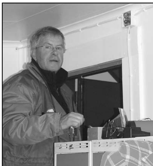
Uffe Svensson lägger ledningar på plats i det nya verkstadsutrymmet.
